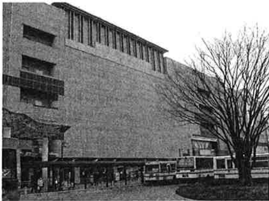
施工前 某駅ビル 一般的なタイル仕上げ
