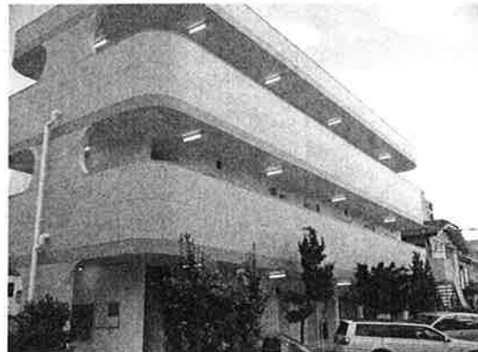
施工後 新築同様の仕上がりとなった。
