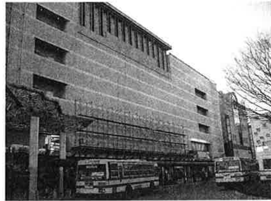
施工後 施工前と変わらない意匠性をもっている。
