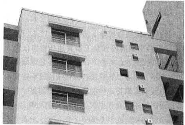
写真-4 平面部（施工後）
