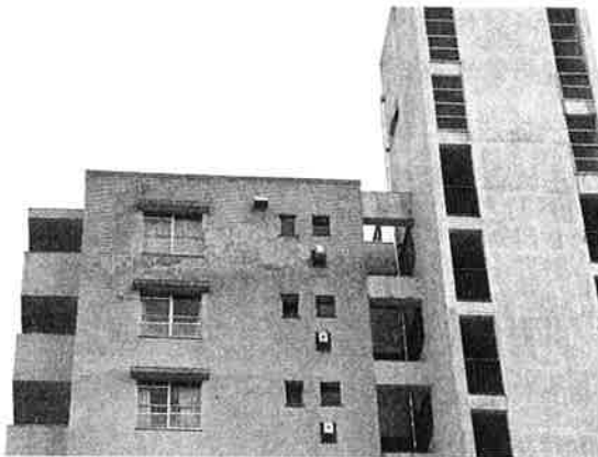
写真-3 平面部（施工前）
