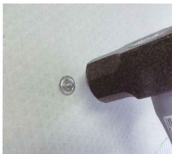
GNSアンカーピンを 1.5ポンドのハンマーで打ち込む
