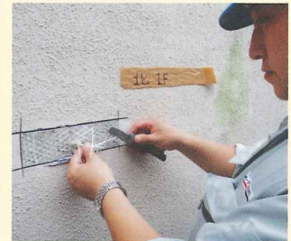
GNSネット抜き取り
