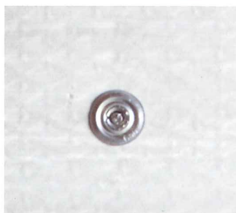
GNSアンカーピンを 1.5ポンドのハンマーで打ち込む
