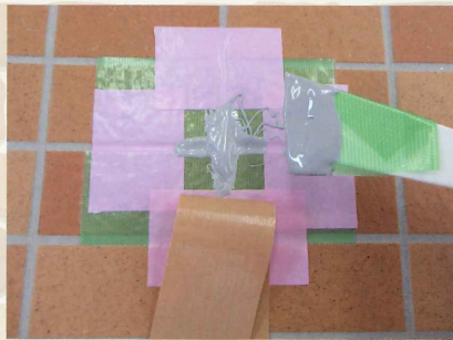
② ガイドテープを貼り付けて目地部にエポキシ系接着剤塗布
