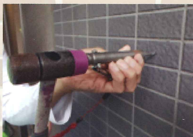
⑦ GNSアンカー打込み
