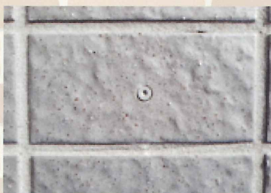
⑧ GNSアンカー打込み完了
