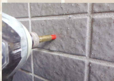
④ 座掘り作業
