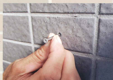
⑥ GNSアンカー挿入
