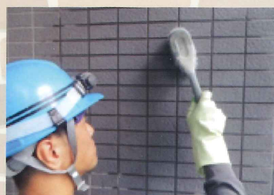
⑨ 洗浄作業
